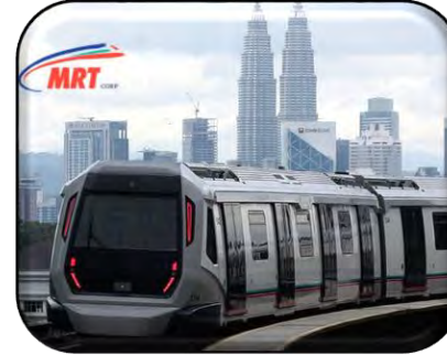
INFRASTRUKTUR & KEMUDAHAN AWAM
