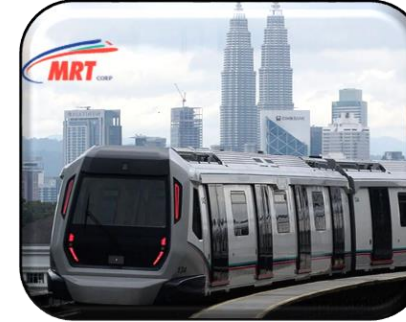
INFRASTRUKTUR & KEMUDAHAN AWAM
