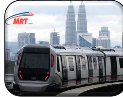
INFRASTRUKTUR & KEMUDAHAN AWAM
