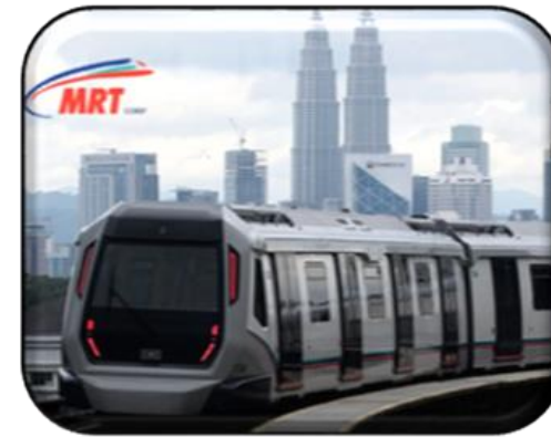
INFRASTRUKTUR & KEMUDAHAN AWAM
