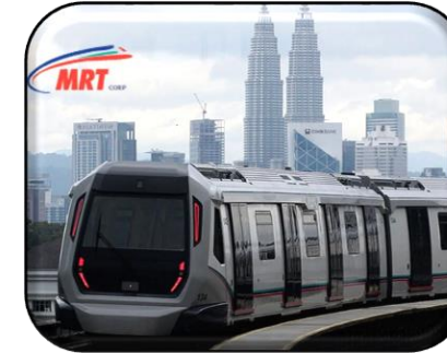
INFRASTRUKTUR & KEMUDAHAN AWAM
