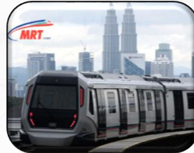
INFRASTRUKTUR & KEMUDAHAN AWAM
