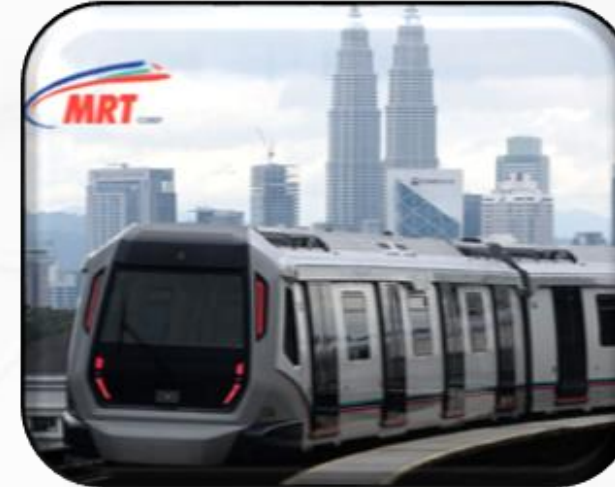
INFRASTRUKTUR & KEMUDAHAN AWAM
