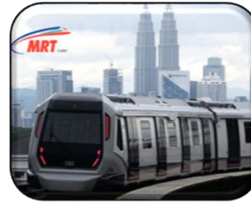
INFRASTRUKTUR & KEMUDAHAN AWAM
