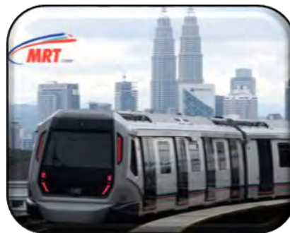
INFRASTRUKTUR & KEMUDAHAN AWAM
